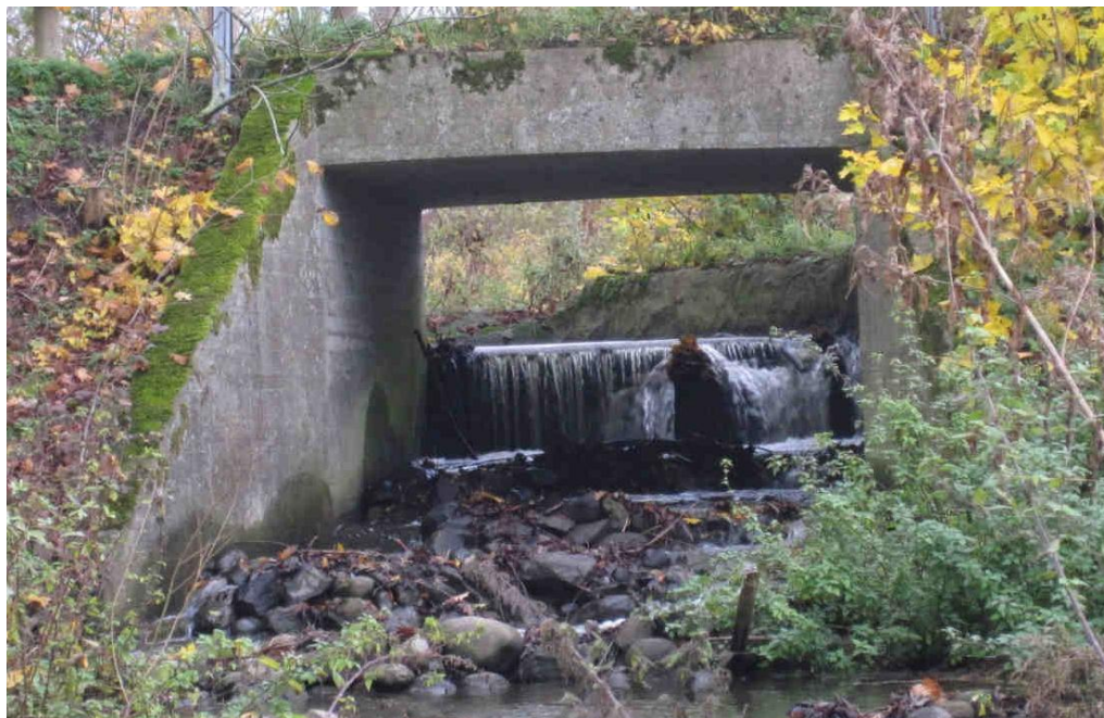
Billede 2: Vejunderføring ved opstemningen.
