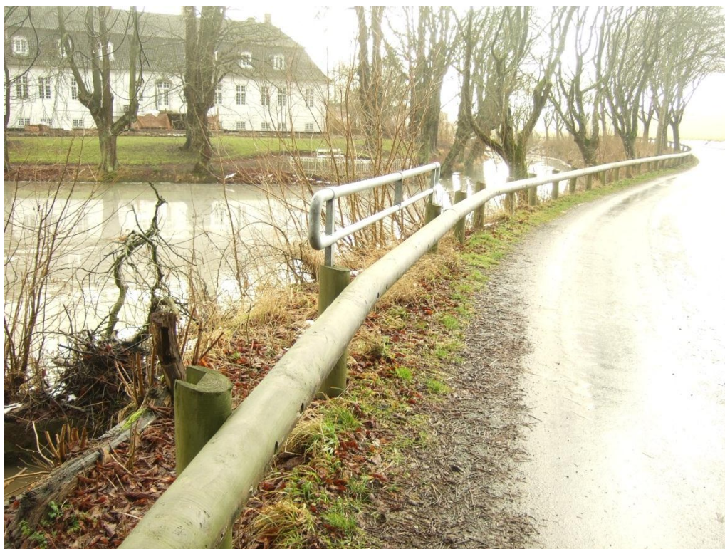
Billede 10: Ved eksisterende underføring samt forbi voldstedet er der i dag etableret et autoværn. Ved etablering af ny rørunderføring længere oppe i skoven, undersøges det om der er behov for etablering af yderligere afskærmning.
